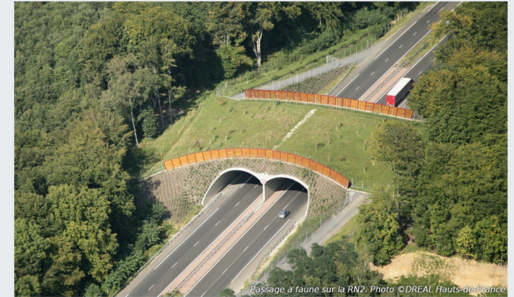
Passage à faune sur la RN2. Photo ©DREAL Hauts-de-France
